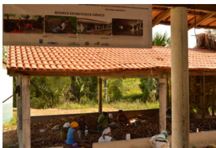
Galpão da unidade de beneficiamento do coco babaçu da RESEX do Ciriaco.
